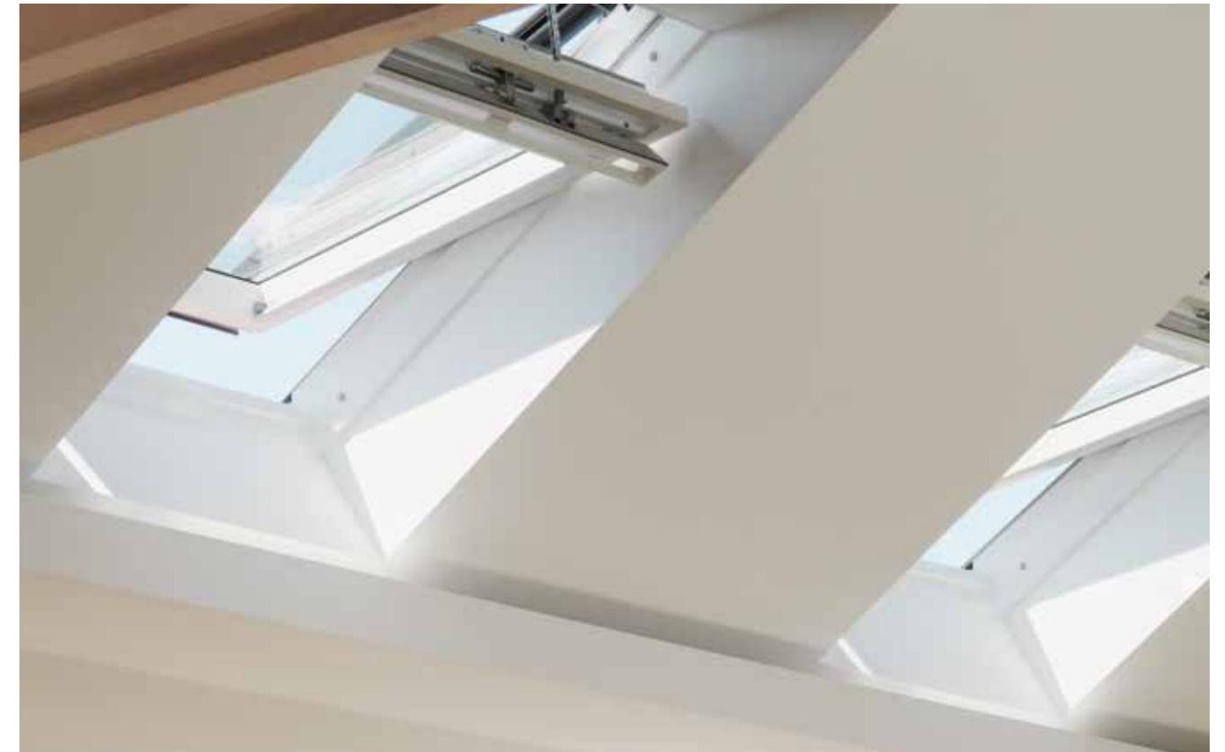
Kattoikkunaryhmän asentaminen lisää tuuletuksen tehoa nk. savupiippuvaikutuksen ansiosta.
